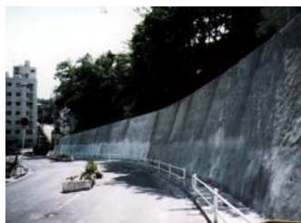
既設擁壁補強工事: コンクリート吹付仕上がり
