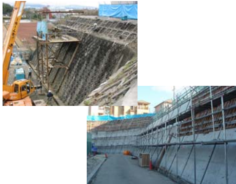
既設擁壁補強 (施工事例 6), 張りコンクリート仕上がり
