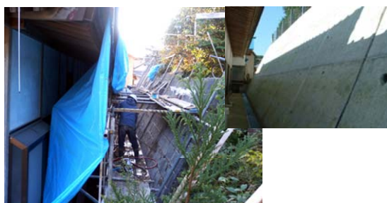
既設擁壁補強工事: 民家からの離れ最小 1.7m, 人力削孔 (施工事例 1), 張りコンクリート仕上がり
