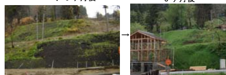
地山補強 (施工事例 3 の一環), 緑化仕上がり
