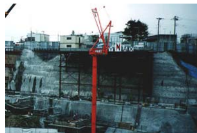
マンション建設工事にもなる仮設土留め工
