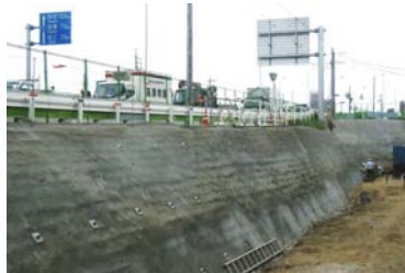
国道 1 号線拡幅工事にもなる切土仮設土留め工 (施工事例 4)
