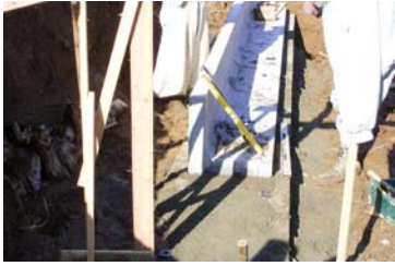
① パネル基礎の施工
