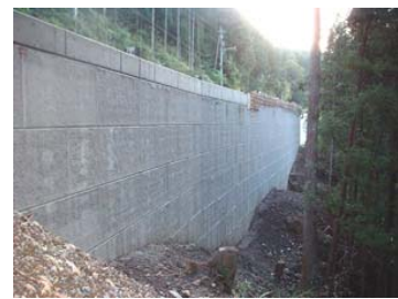
道路（拡幅工事）
