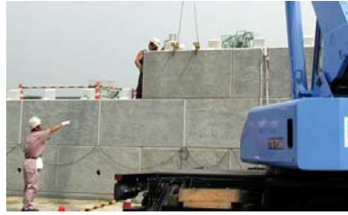
② パネルの積上げ、連結
