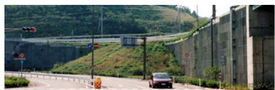
道路 国土交通省北陸地方整備局金沢工事事務所（当時） 試験フィールド工事
