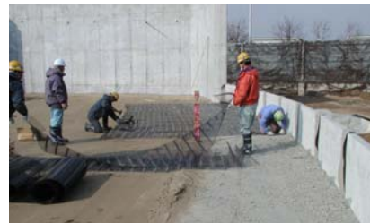
⑥ ジオグリッドの敷設
