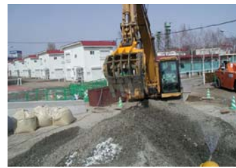
③ 改良土の攪拌、混合
