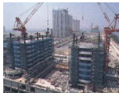
臨海副都心台場 AL 街区 A1・A2 棟
